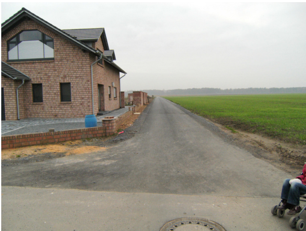
Bild 5 neu asphaltierte Wirtschaftsweg in Richtung Lamertzweg
